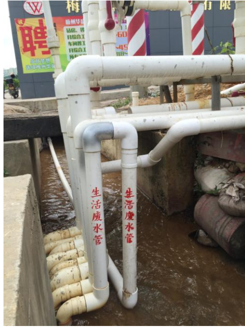
进入华禹污水处理厂
